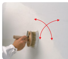
Aplicarea produsului Putzgrund cu ajutorul unei bidinele.
