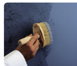
ArteLasur Color se aplică într-un singur strat, cu ajutorul periei prin mișcări încrucișate. (cod. 080400)
