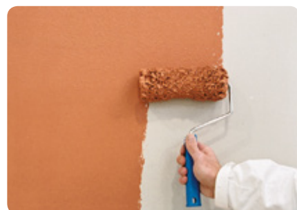
Se aplică un strat intermediar de Putzgrund, nuanțat în culoarea recomandată.
