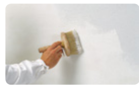
Aplicarea produsului Putzgrund cu ajutorul unei bidinele
