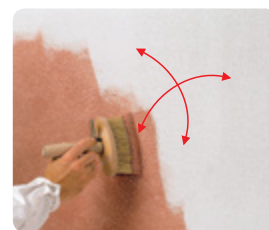
Aplicarea lazurii cu ajutorul unei perii (cod. 080400).
