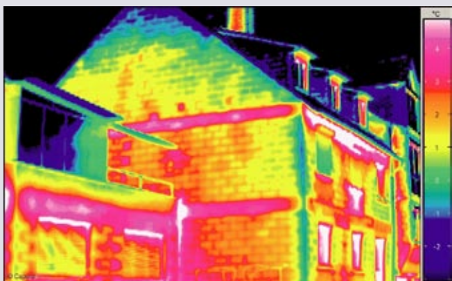
Imaginea 1. Prin tehnica termografiei, pierderile de căldură sunt evidențiate de suprafețele roșiatice.
