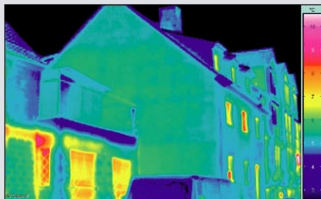
Imaginea 2 indică termografia aceleiași case după montarea unui sistem profesional termoizolant.
