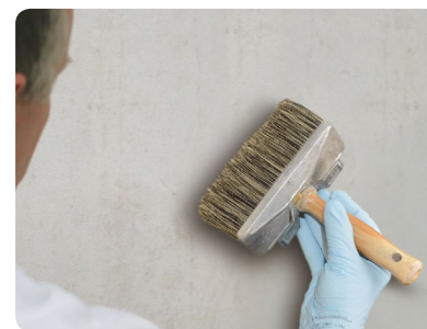
Desprăfuire și grunduire
