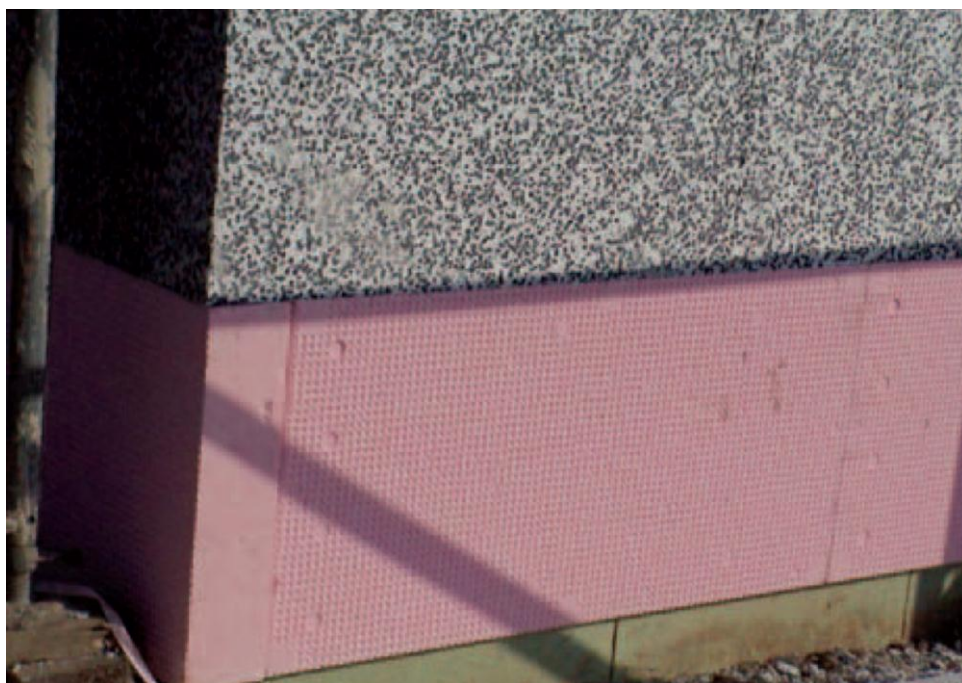
Execuția corectă a trecerii de la termoizolația fațadei la cea a soclului
